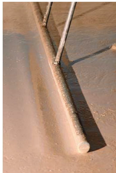
Durch leichtes vibrieren wird der Mörtel einnivelliert
