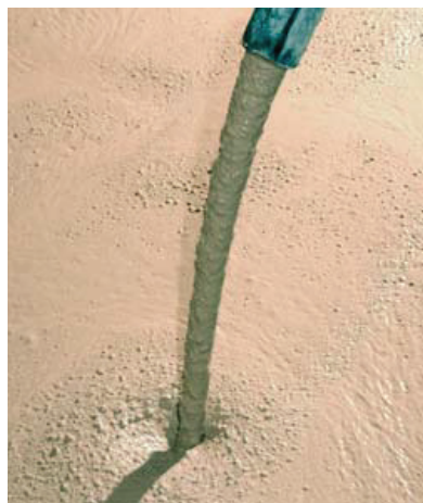
Eingiessen des Mörtels
